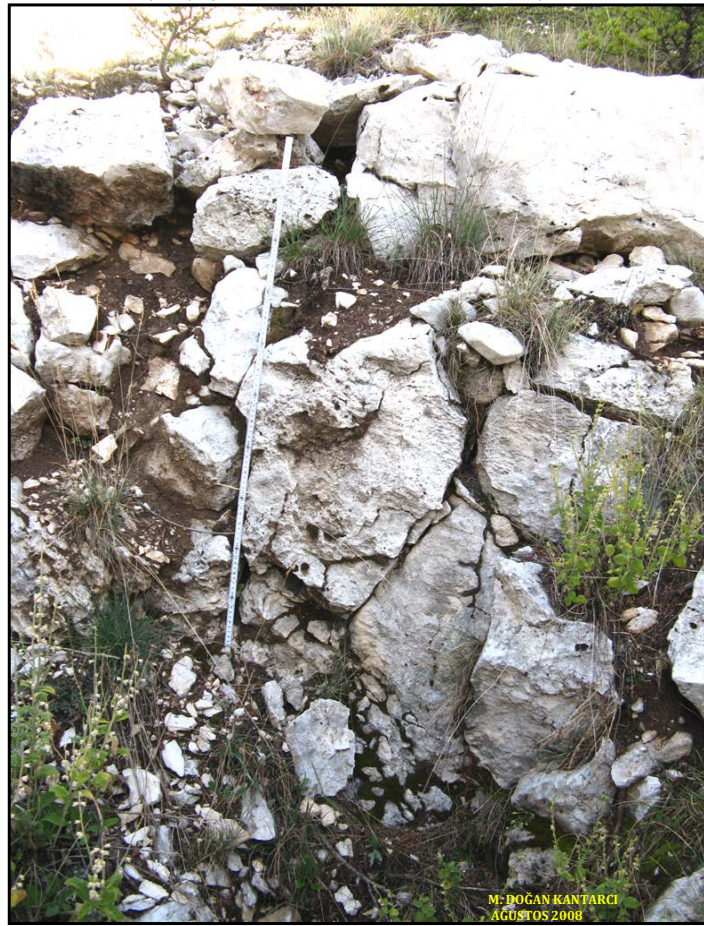
RESİM 1. KİREÇ TAŞI ÇATLAKLARI ARASINDA TOPRAKLAŞMA
